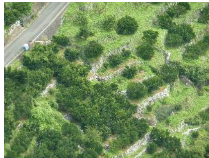
(石灰岩で築かれた石垣)
